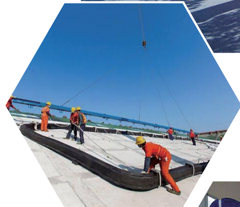
▲2020年4月,具有“株洲血统”的高性能橡胶止水带首次在沉管隧道施工中使用,摆脱进口依赖 受访企业供图
