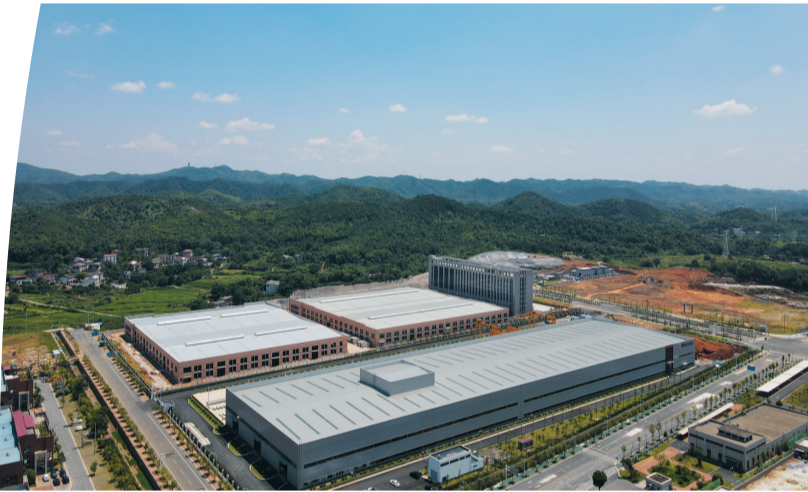
▲装配式构件生产基地
