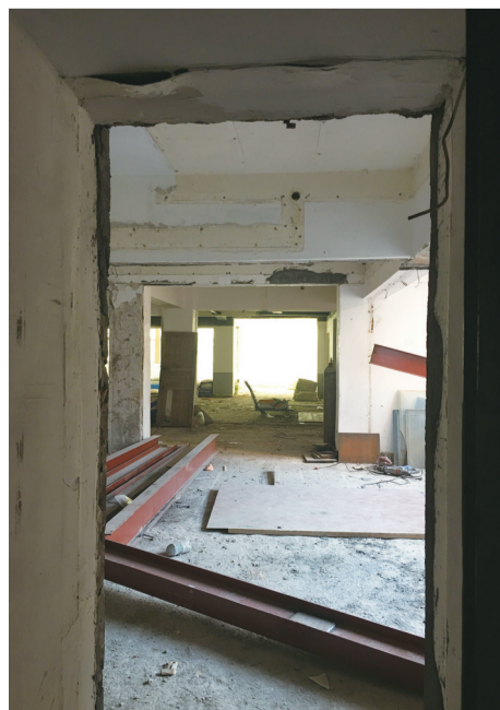
施工现场,一些墙体被拆除。刘平 摄
