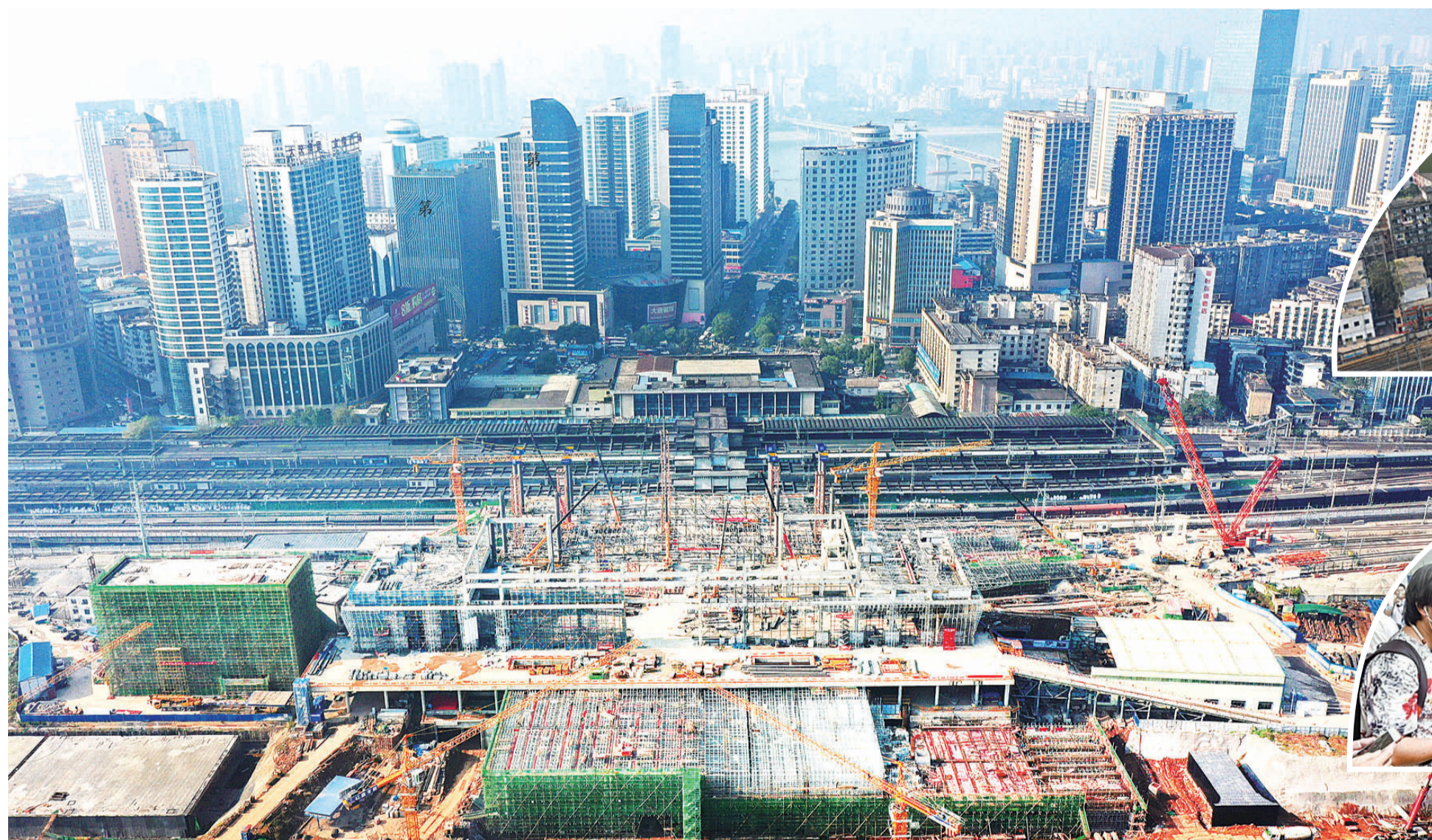
▲2020年12月22日,株洲站改扩建工程建设现场
