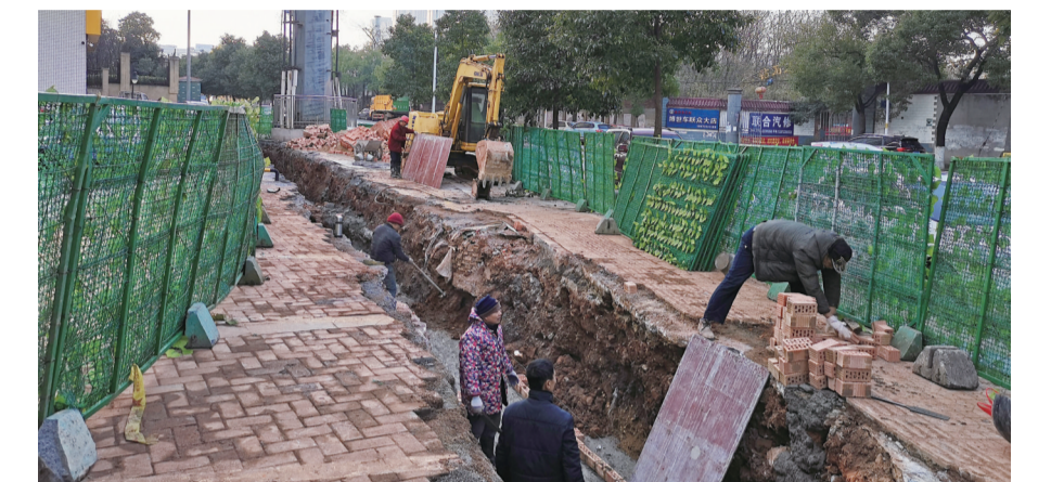
▲昨日,现场正在施工 记者 姚时美 摄
