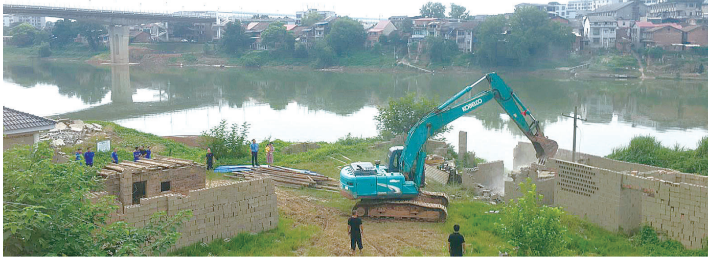
拆除违章建筑。涑口区河长办供图
