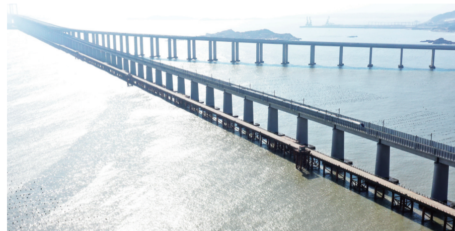
▲12月26日,列车经过福平铁路平潭海峡公铁大桥
