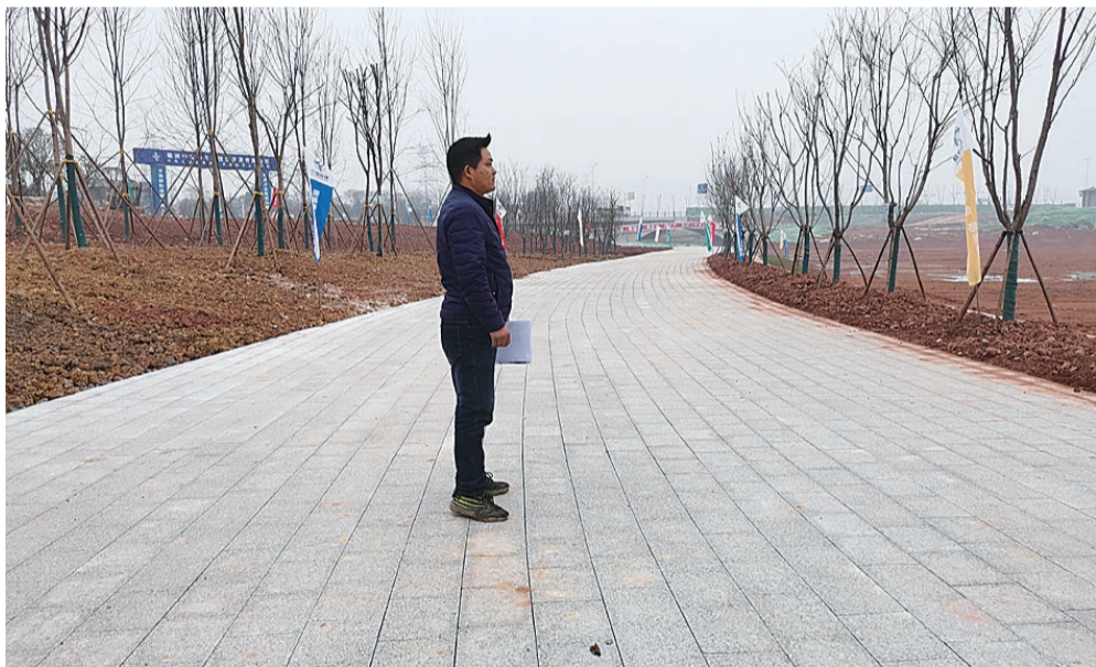
▲地上铺的火烧板,就是罗先生带着班组的农民工做完的 记者 姚时美 摄
