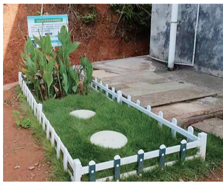
▲农村单户改厕治污处理系统 通讯员供图
