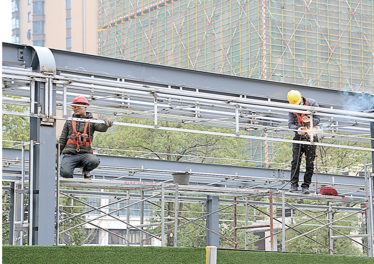
正在进行装饰装修施工的智轨湖南工大站。 廖明 摄
