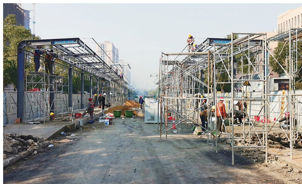
▲站台施工正在加紧进行 记者 戴凇 摄
