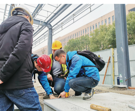
▲施工人员测量地砖数据 记者 戴凇 摄
