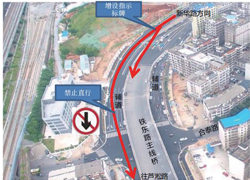
▲铁东路与合泰路交叉口
