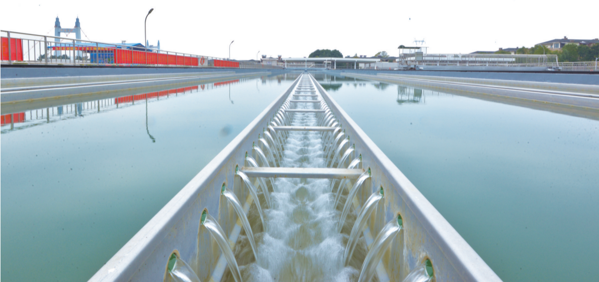
四水厂扩建工程竣工并投产。通讯员 供图
