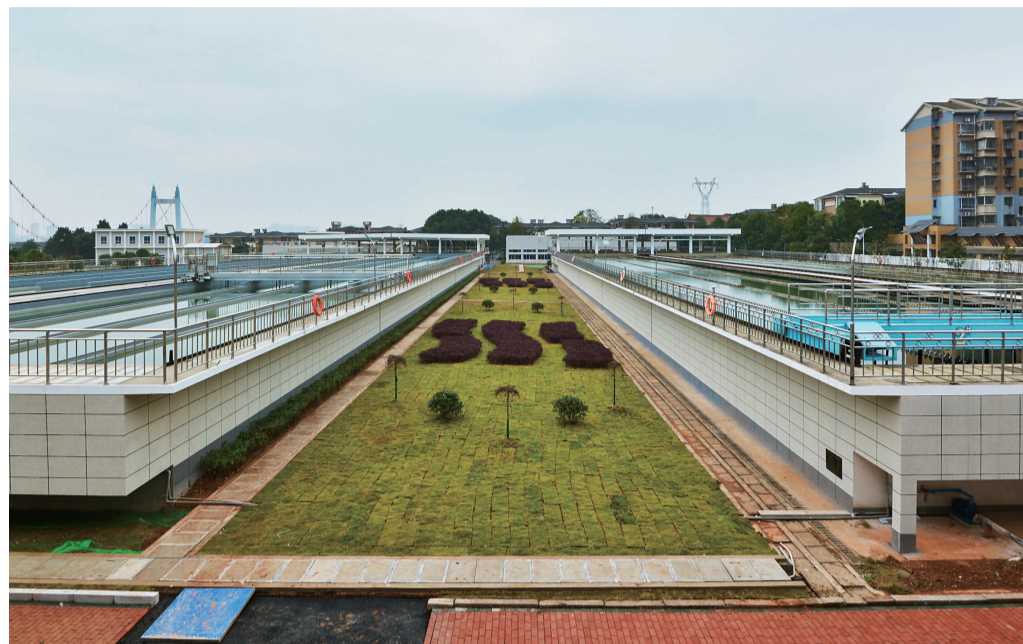
▲四水厂扩建工程昨竣工 通讯员供图
