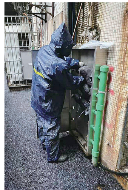
▲市水务集团工作人员对供水设施进行包扎防冻 通讯员供图
