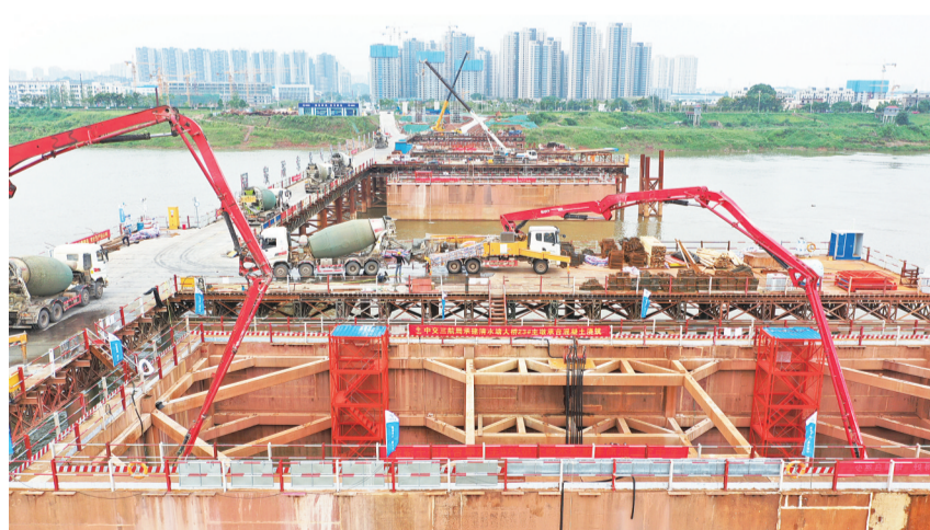
清水塘大桥现场建设情况。受访者供图
