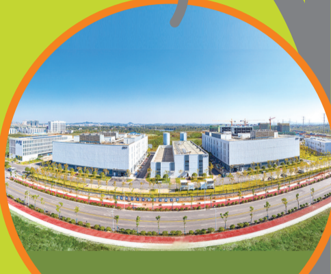
中国移动(湖南株洲)数据中心
