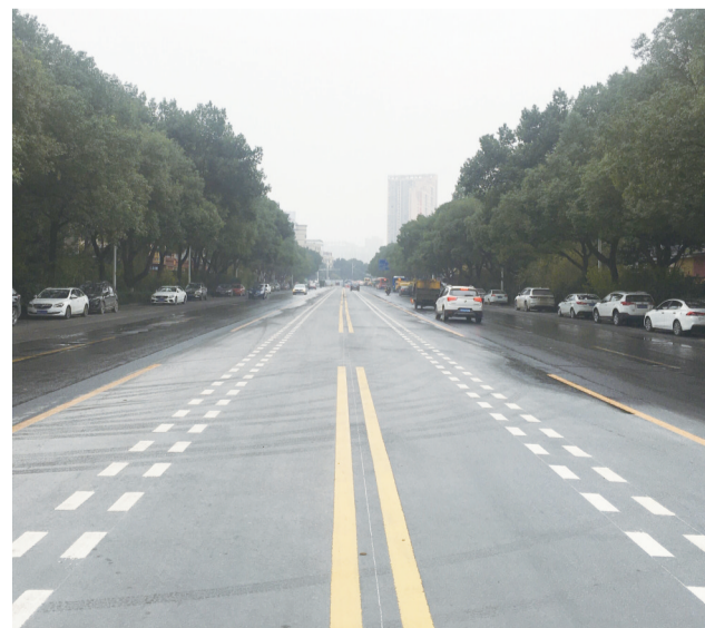
12月11日，位于天元区泰山路至天伦路之间的长江南路路段，施工围挡已经拆除，路面的智轨专用道施划成型。据了解，智轨车道设置在道路中间，双向占用2个车道，为专用车道。其中位于株洲大桥上的智轨专用道允许社会车辆通行。
