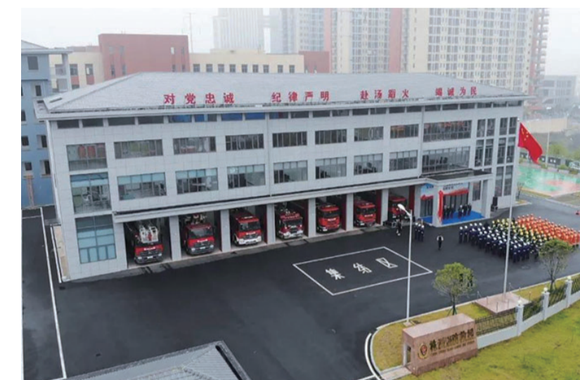
▲该站建设规模属于城市二级消防站 通讯员供图
