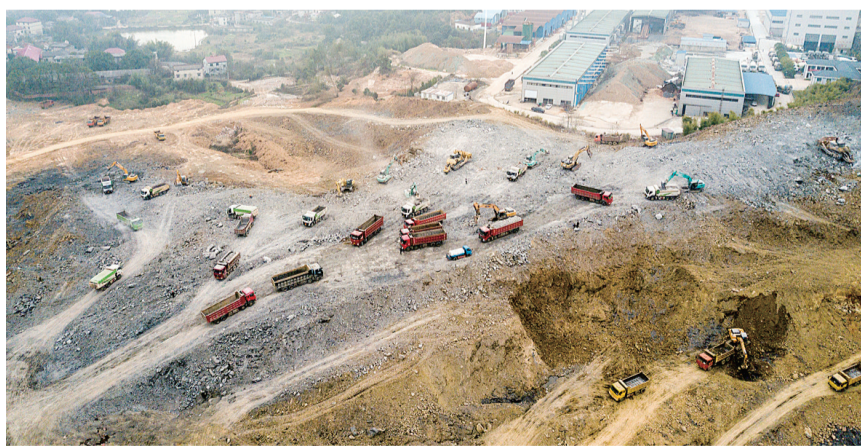
荷塘区金山新城三一智慧钢铁城项目建设现场(资料图)。全媒体记者 刘振摄
