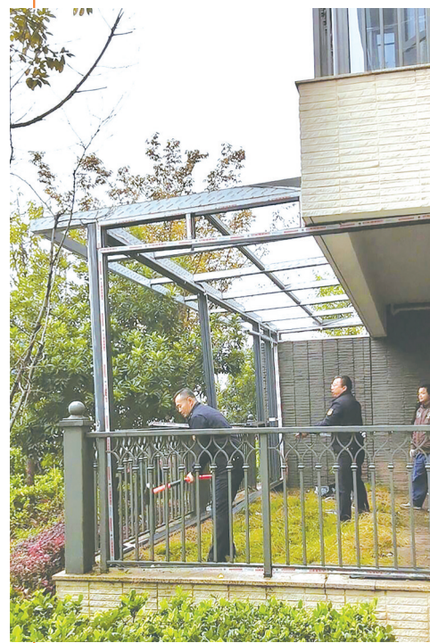
治违队员对搭建物进行强制拆除。刘平 摄
