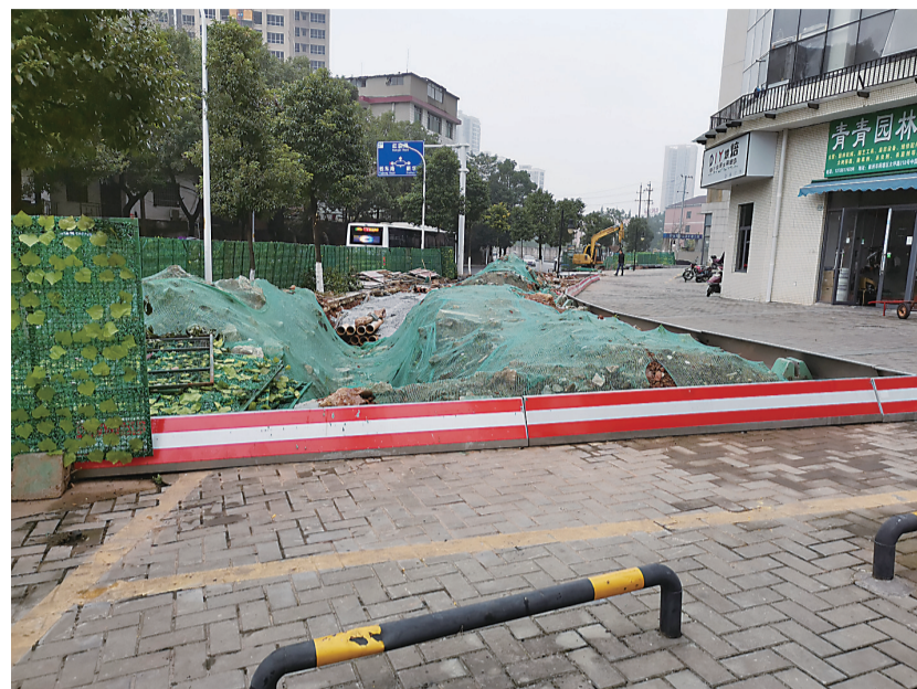
▲停车坪因施工被挖开,并用围挡挡住 记者 姚时美 摄
