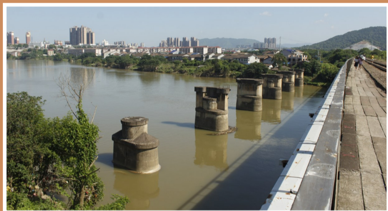
▲醴陵阳三石铁路桥,由詹天佑主持修建,现存桥墩 通讯员 王彦宏 摄
