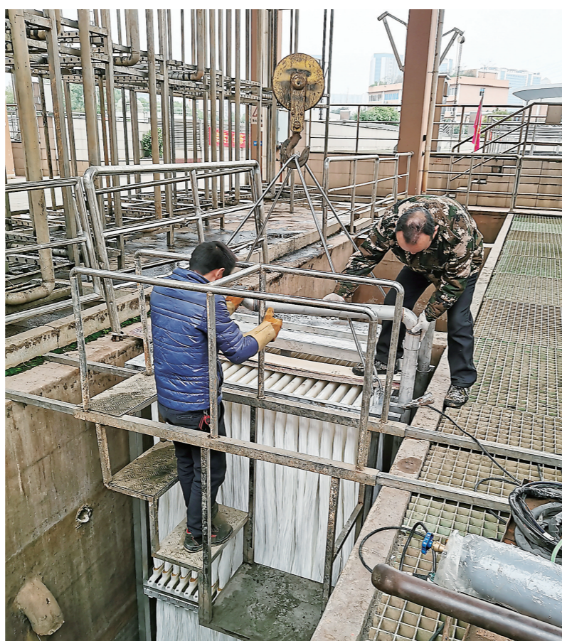
“超滤膜”膜帘正在被放入膜池内。易蓉/摄
