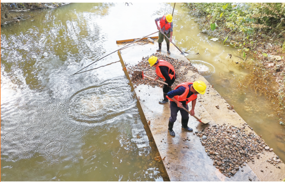
工人正向枫溪港底回填鹅卵石。廖明 摄
