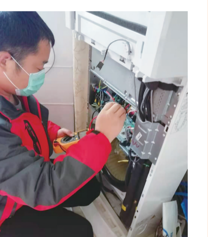
汪顺在用户家修理空调。易蓉 摄
