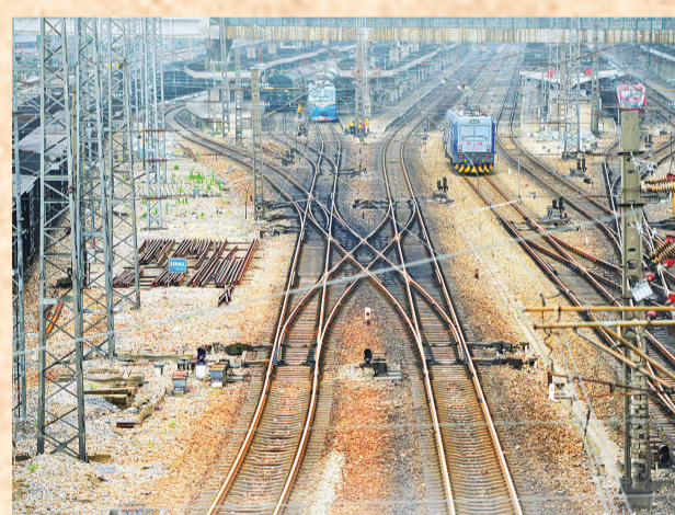
▲从新华桥上看到的铁路枢纽景观
