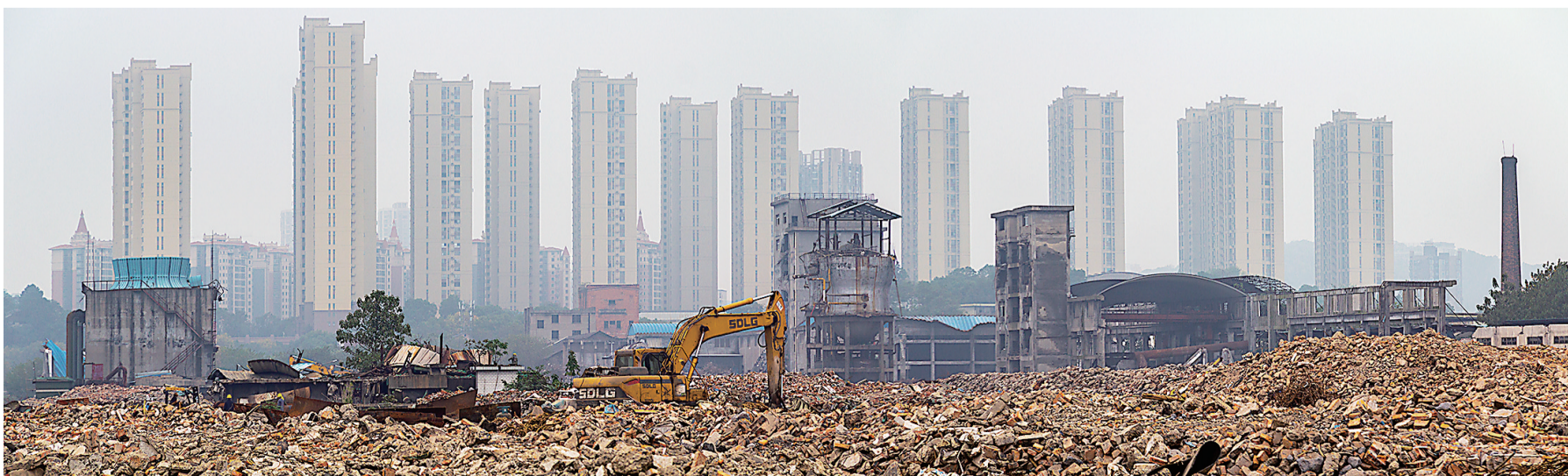
湘氨厂区拆除中,远处的高楼林立
