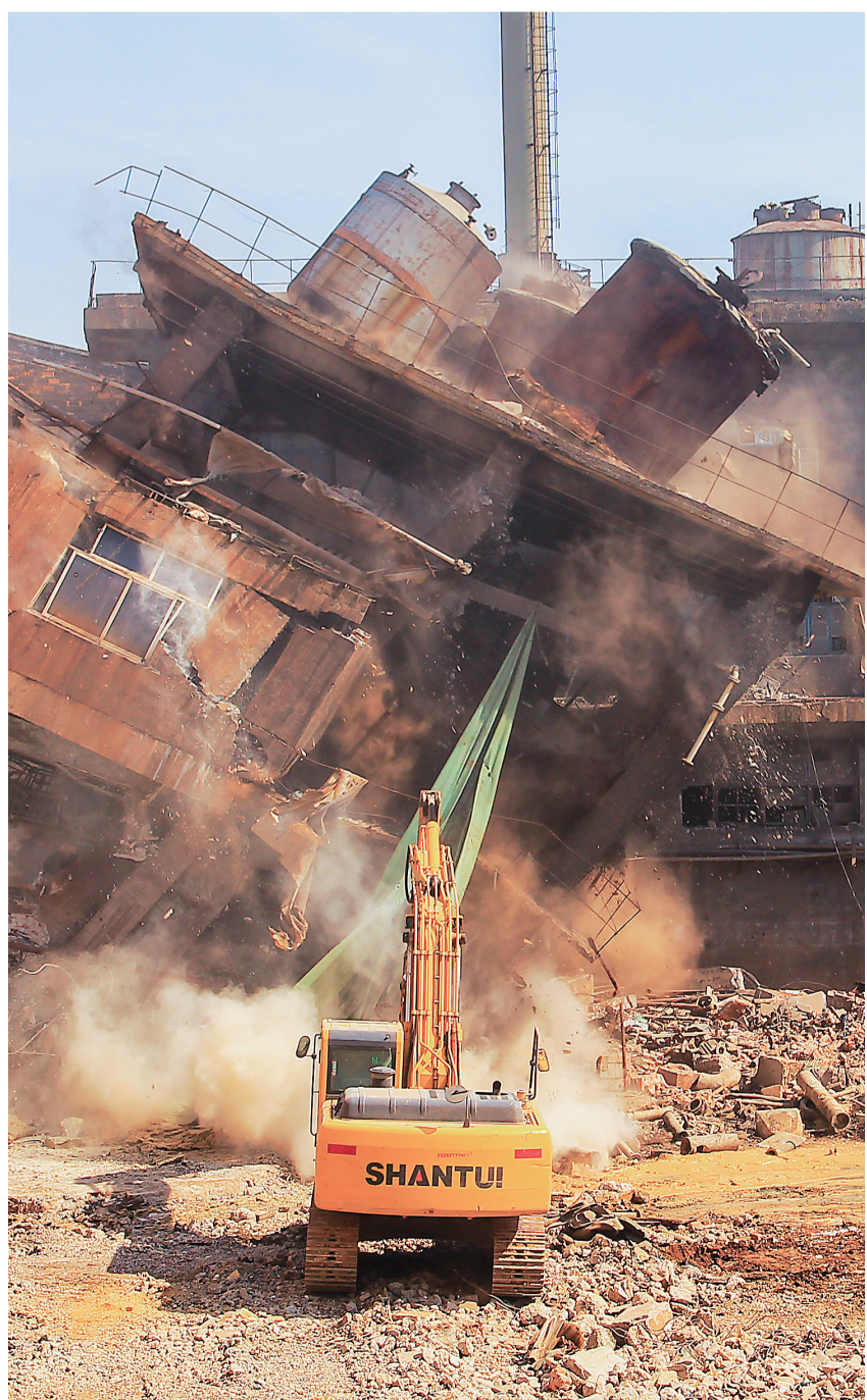
株化磁性氧化铁厂房拆除中
