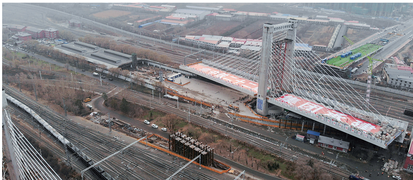
这是哈尔滨市哈西大桥转体工程项目现场(11月12日摄，无人机照片)。新华社记者 王松 摄
