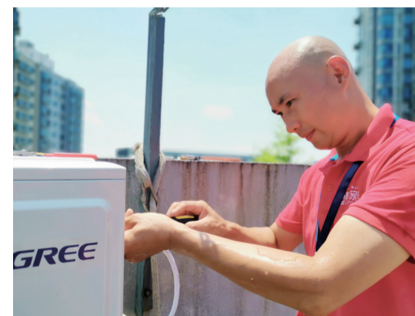
▲陈铁军在安装空调
