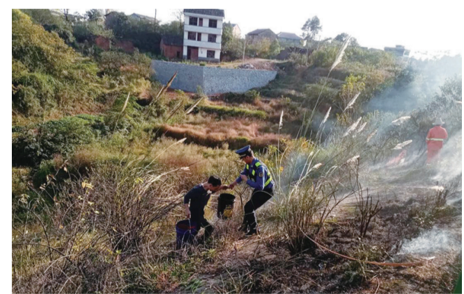
▲高速护坡起火,多部门联合扑救 通讯员供图
