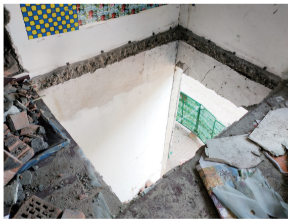
▲一层、二层之间的楼板被凿开 记者 廖智勇 摄
