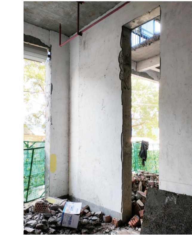
▲门面隔断墙被凿开的门洞 记者 廖智勇 摄
