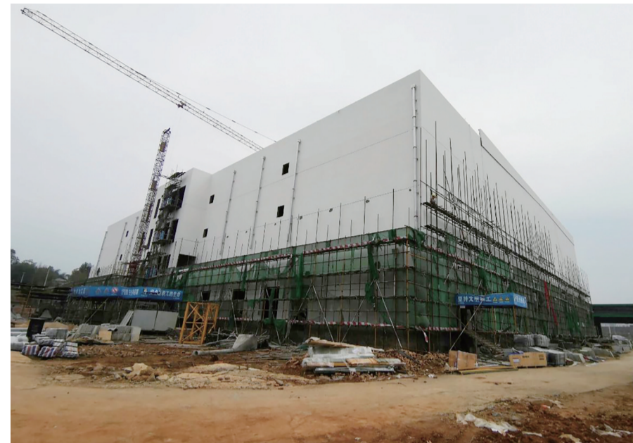
▲冷库已完成内、外墙粉刷以及外墙漆底漆喷涂,外墙脚手架正在进行拆除 通讯员供图
