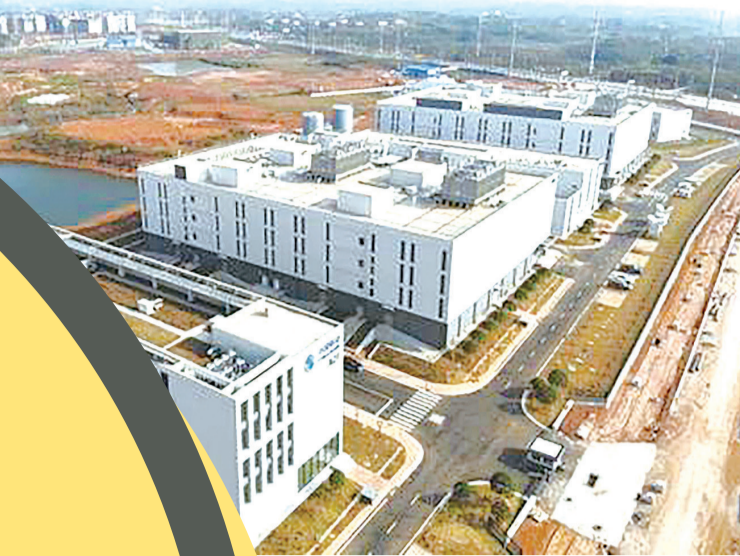
中国移动湖南数据中心。(通讯员供图)
