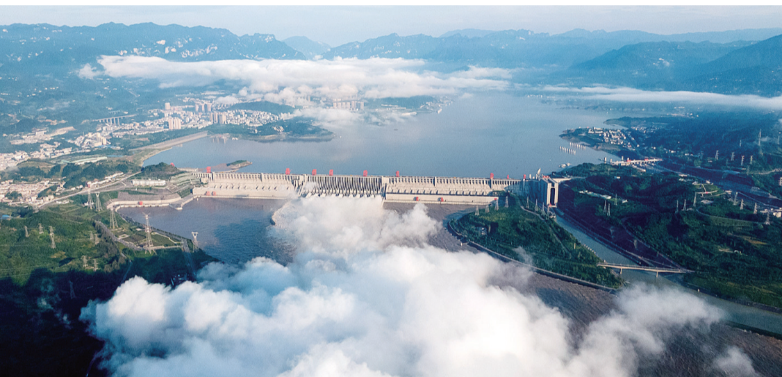
长江三峡水利枢纽工程开启泄洪深孔泄洪。新华社记者 肖艺九 摄
