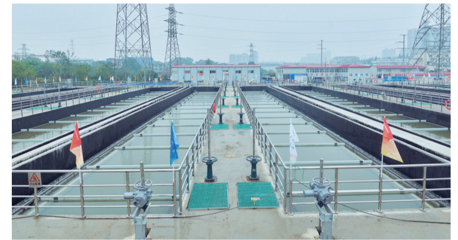
▲白石港(湘江入口-学林路)水环境综合治理PPP项目现场 通讯员供图
