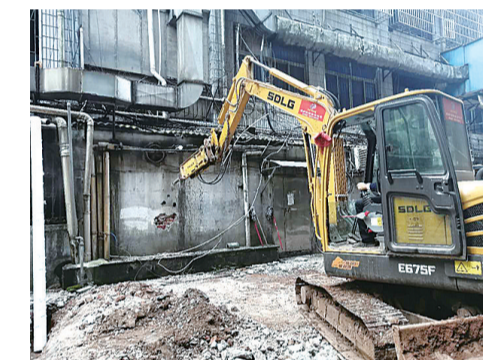
▲推土机正在拆除封堵“生命通道”的围墙 通讯员供图
