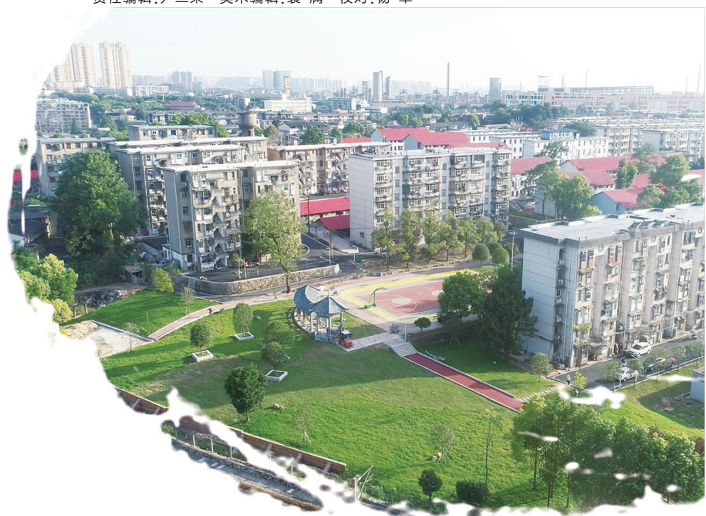
改造后的报亭小区。通讯员 供图
