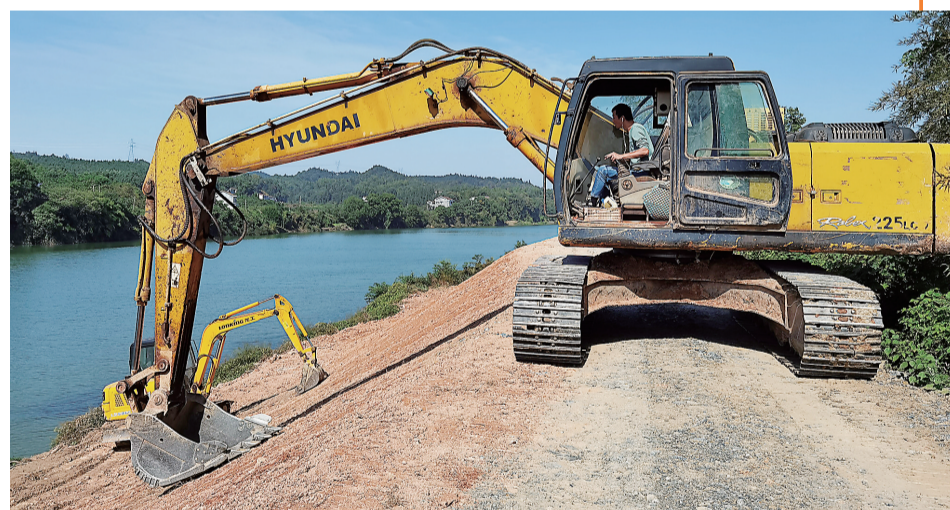
图为挖掘机正在作业。王军 邓立平 摄
