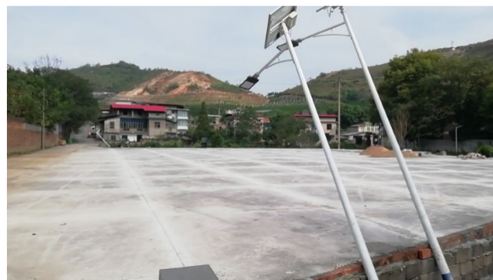
▲清竹社区健身休闲广场正在建设中 通讯员供图
