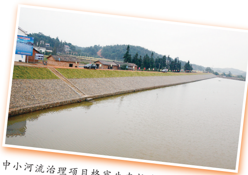
中小河流治理项目格宾生态护坡工程
