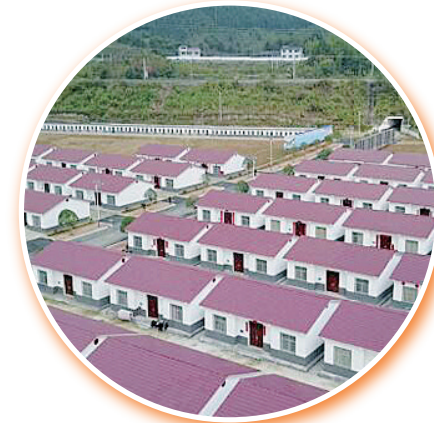
炎陵县易地扶贫搬迁县级集中安置区
