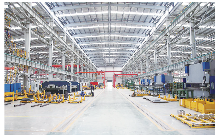
轨道交通牵引装备部件生产基地建设项目1号厂房
