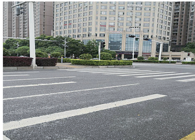
▲大雨过后,整治后的黄路路交叉口水无积水现象
