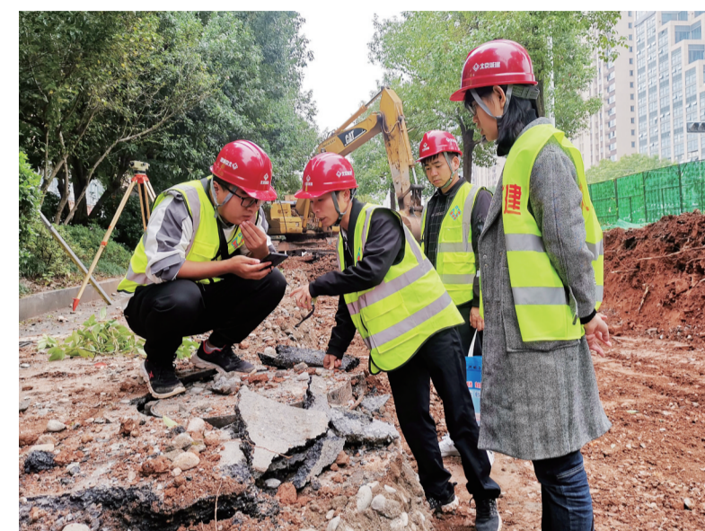
▲工程人员在现场讨论施工方案 记者 戴凛 摄
