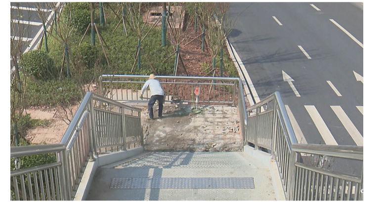
▲施工人员正在作业 记者 陈驰 摄
