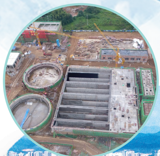
建设中的金山污水处理厂
