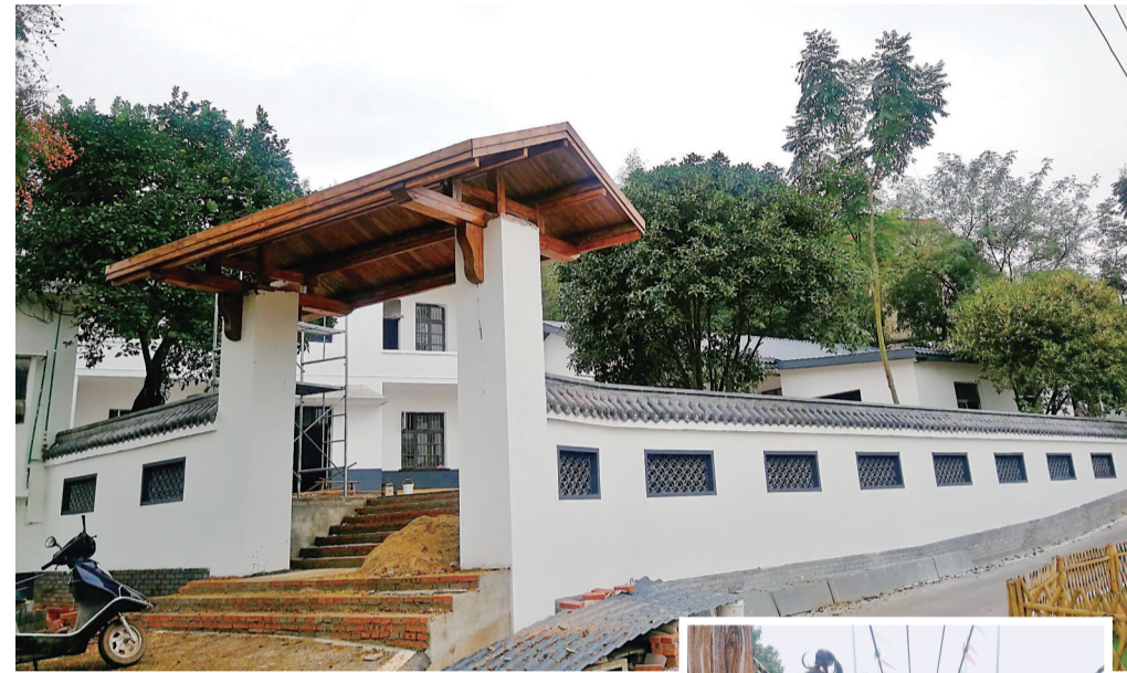
▲冯兵家的装修翻新工程正在进行中,预计年底完工
