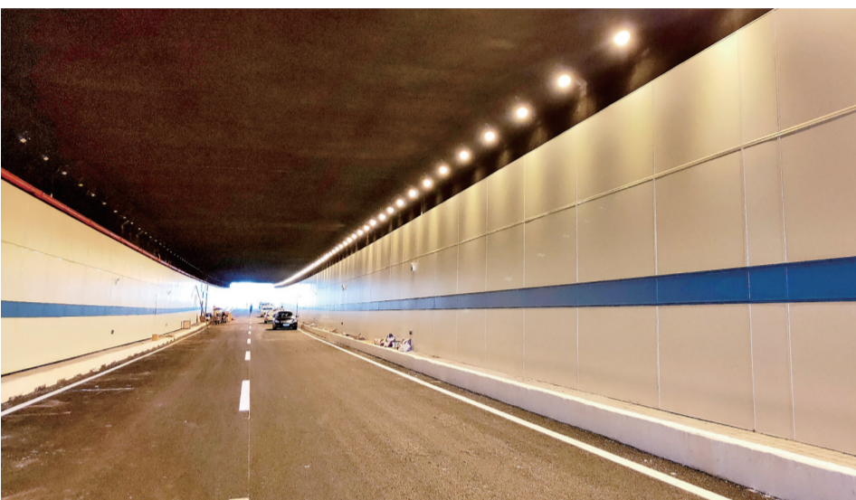
响石广场隧道内部 首席记者 李卉 摄
