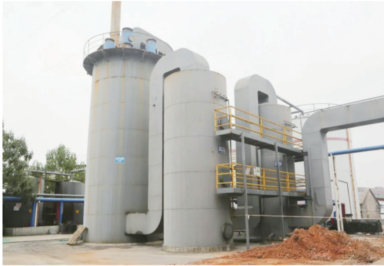
▲“帅旗防水”正在进行煤改气改造,以解决大气污染问题 通讯员 供图
